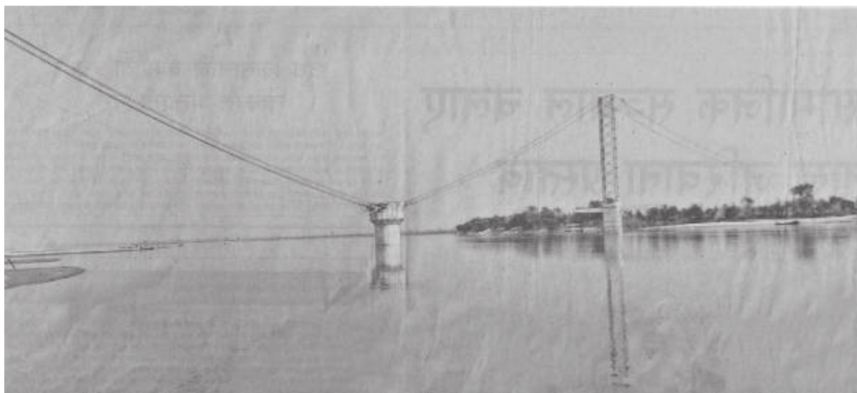
पश्चिम नवलपरासीको सुस्तामा निर्माणाधीन ठोलुङ्गे पुल । दुई वर्षमा सकिनुपर्ने पुल आठ वर्षमा पनि बनेको छैन ।
