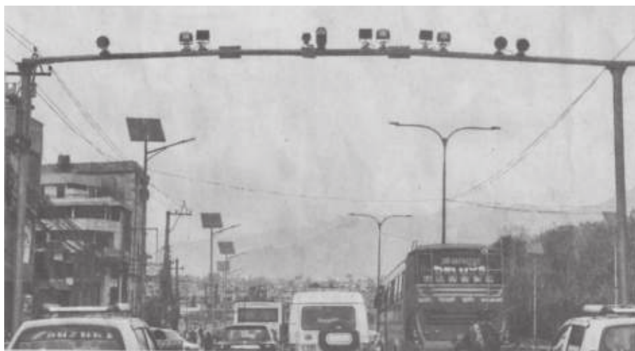
काठमाडौंको कोटेश्वरको सडकमा जडान गरिएको "एनपीआर" (अटोमेटिक नम्बरप्लेट रिकग्निशन क्यामेरा) । का.म.पा.को सहयोगमा उपत्यका प्रहरीले जडान गरेको आधुनिक प्रविधिकृत उक्त क्यामेराले गाडीको नम्बरप्लेट र चालकको सिटसम्मकै गतिविधिको फोटो खिचेर सर्भरमा पठाउने गर्दछ ।
