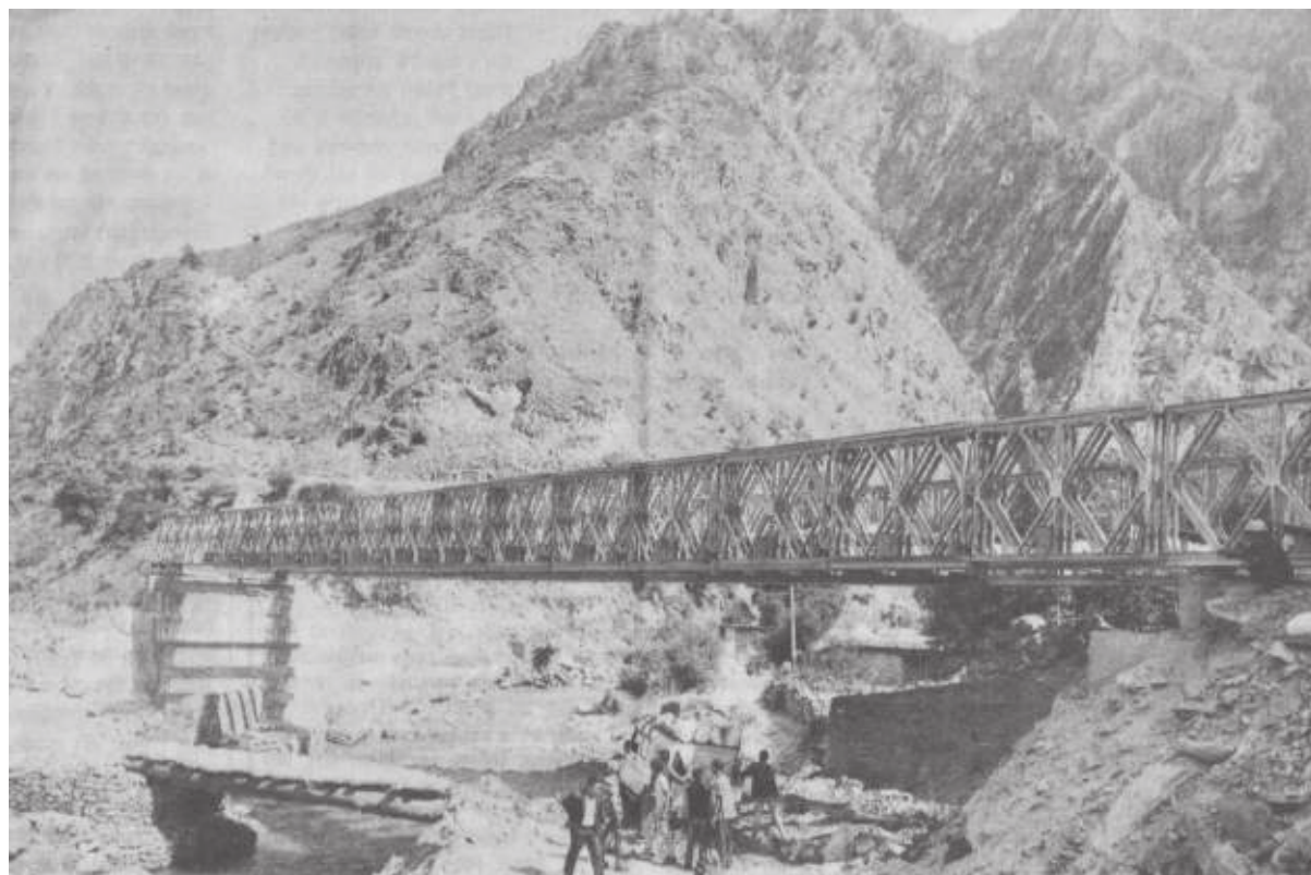
निर्माणाधीन बेलिब्रिज पुल: भेरी करिडोरअन्तर्गत पर्ने डोल्पाको ठूलीभेरी नगरपालिका-३ स्थित रुपगाडमा निर्माणाधीन बेलिब्रिज पुल ।
